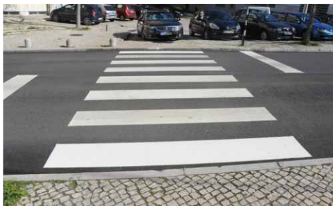
Pavimentação e sinalização horizontal da Rua Oliveira Martins, no Feijó.
