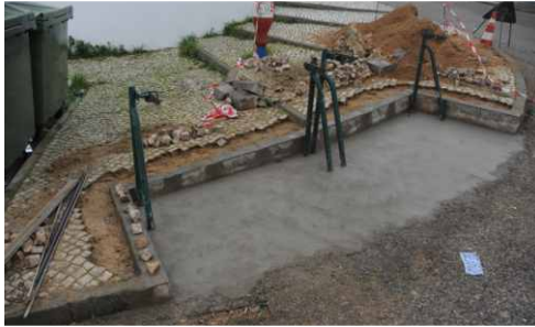
Requalificação da via pública, execução de reentrâncias para colocação de contentores do lixo, Rua Armando Cortesão, em Vale Flores.
