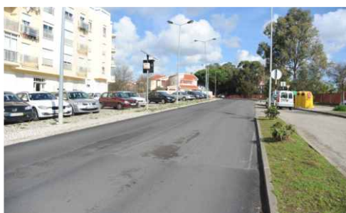
Pavimentação da Rua de Vale Flores.
