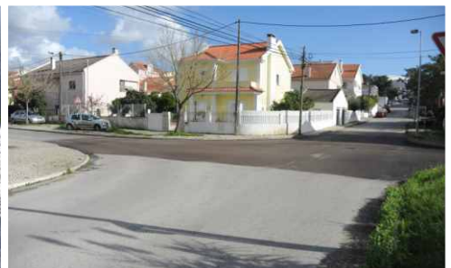
Pavimentação do cruzamento entre a Rua Piteira Santos e a Rua de Vale Flores.
