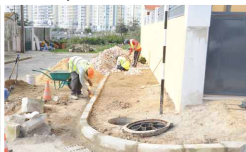
Requalificação dos passeios na Rua Vale do Torrão, Feijó.
