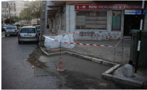
Requalificação da via pública com execução de reentrâncias para colocação de contentores RSU na Rua Bento de Jesus Caraça, no Laranjeiro.
