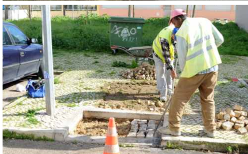
Requalificação da via pública, execução de reentrâncias para colocação de contentores RSU na Rua Luís Sttau Monteiro, em Vale Flores.
