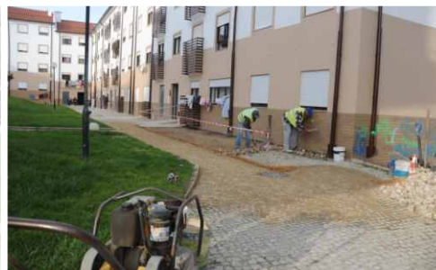
Requalificação da via pública, regularização do passeio da Praça Jacinto Ramos, Feijó.
