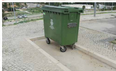
Requalificação da via pública, alargamento de reentrâncias para colocação de contentores do lixo, na Rua D. Duarte, Laranjeiro; Rua do Feijó; Rua Adolfo Coelho, Feijó.
