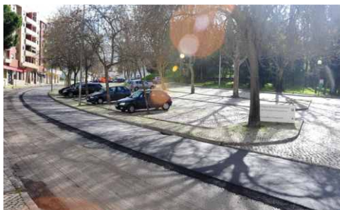
Pavimentação da Rua dos Castanheiros e respetiva sinalização horizontal da via.
