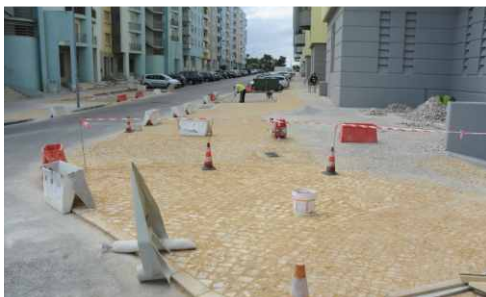
Requalificação da via pública, ruas Maria Judite Carvalho e Virgínia Moura, no Feijó: Regularização do passeio; Marcação de passadeira para peões; Colocação de sinalética vertical; Alargamento da bolsa de estacionamento.
