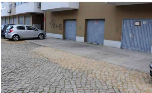
Regularização da calçada na Rua dos Eucaliptos, no Laranjeiro.
